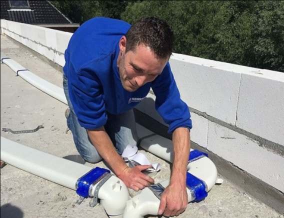
Alle leidingen komen naar een centrale collector op de eerste verdieping. Daardoor kon men de ventilatieleidingen voor die verdieping probleemloos boven op het plat dak kwijt
