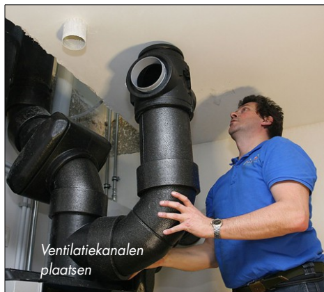
Alle leidingen komen naar een centrale collector op de eerste verdieping. Daardoor kon men de ventilatieleidingen voor die verdieping probleemloos boven op het plat dak kwijt
